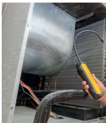
चित्र 4.2.17: इलेक्ट्रॉनिक रेफ्रिजरेंट डिटेक्टर का उपयोग करके रिसाव का पता लगाना
